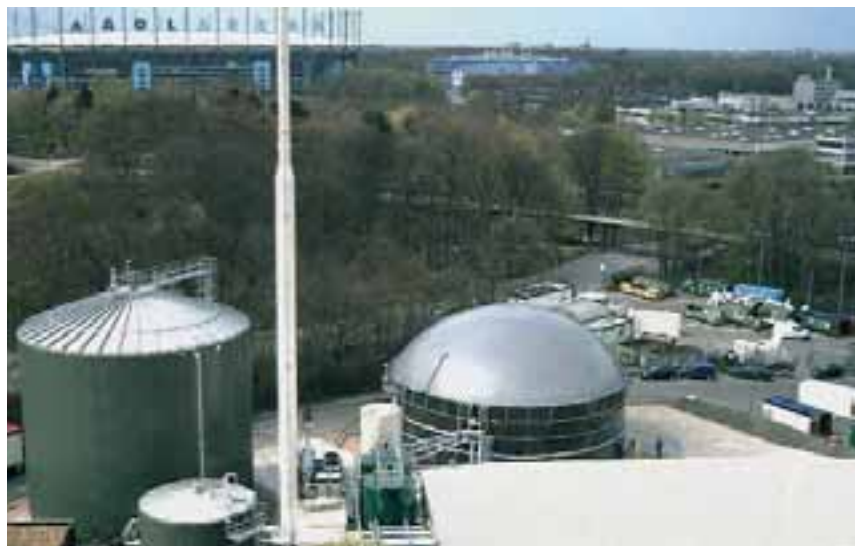
Das Stadion Hamburg deckt seinen Wärmebedarf mit Energie aus einer nahe gelegenden Biogasanlage.
