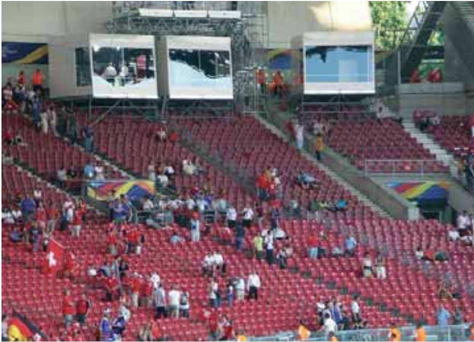
Bei temporären Einrichtungen wie den Presenter Studios in den Stadien wurde auf Rückbau und Wiederverwendbarkeit geachtet. Die Studios waren in Leichtbauweise und in Form eines Baukastensystems konstruiert.
