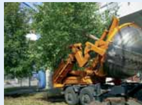
Bei der Sanierung des Nürnberger Stadions gelang es, rund 20 alte Linden zu retten. Die Bäume wurden mit Spezialmaschinen einzeln ausgegraben und nach Ende des Umbaus dicht beim Stadion wieder eingepflanzt.
