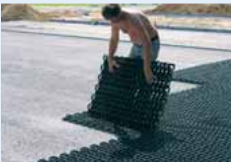
Viele Parkplätze der Stadien sind wasserdurchlässig befestigt. In Köln kamen Platten aus Recyclingkunststoff zum Einsatz.
